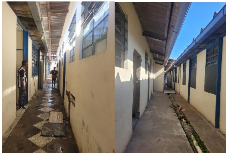
Fotografias 03, 04 e 05: Corredores e área de serviço
