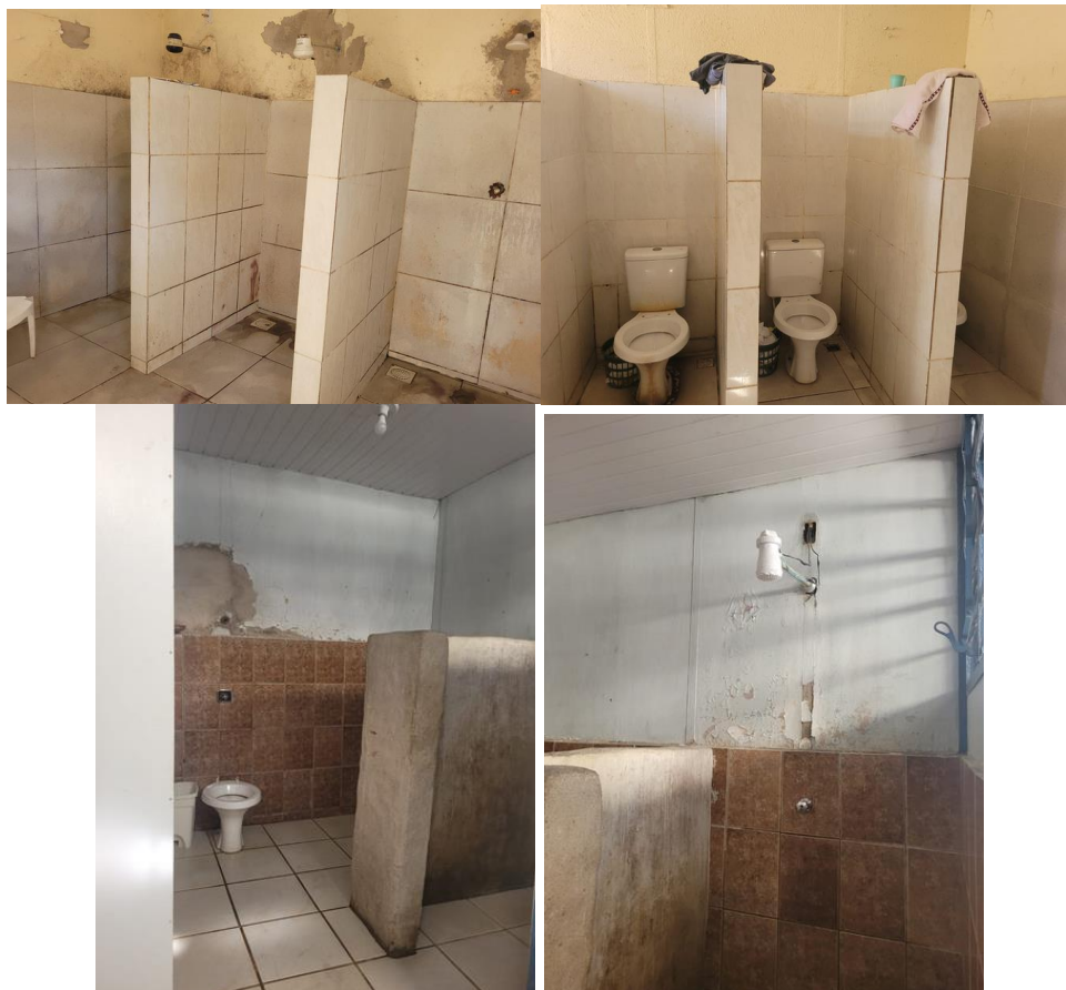
Fotografias 08, 09, 10 e 11: Banheiros
